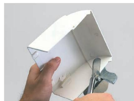
Dopo il taglio e l'asportazione dello spessore, i due elementi dell'angolo variabile esterno possono essere riassemblati.
