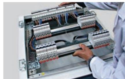
Grazie al telaio estraibile le operazioni di collegamento degli interruttori diventano più facili, permettendo prima il pratico cablaggio a banco e successivamente l'installazione all'interno della cassa a circuito ultimato.
