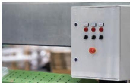
L'elevato grado di protezione IP66 consente di alloggiare gli operatori 74 PS all'interno o all'esterno dei contenitori GEWISS quali i quadri della Serie 46, i centralini d'emergenza 42 RV, le scatole 27 COMBI o le basi di supporto 42 TV.
