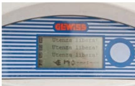
I terminali equipaggiati con sistema di gestione elettronico consentono di contabilizzare e monitorare i consumi in tempo reale. Il display di interfaccia con l'utente e il lettore di chiavette trasponder per la gestione del credito sono alloggiati nella testata.
