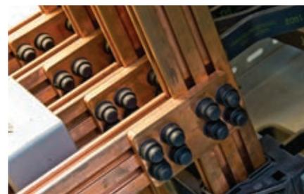
Grazie alla preforatura sulle barre piatte a passo 25mm è possibile effettuare una rapida connessione in barra, bandella oppure in cavo. Inoltre, è possibile effettuare in modo semplice e rapido giunzioni tra barre piatte e barre sagomate utilizzando i giunti dedicati.
