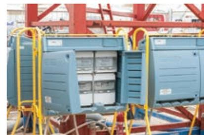
Specifici pannelli aggiuntivi consentono di realizzare differenti configurazioni di quadri, in funzione delle specifiche esigenze di ogni cantiere. Grazie ai pannelli centralini, ad esempio, è possibile ottenere quadri di soli interruttori (fino a 60 moduli), mentre con i pannelli prese si possono ottenere quadri con 12 prese interbloccate.
