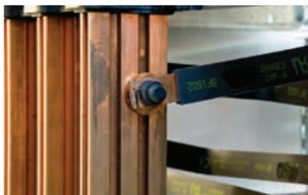
Le connessioni al sistema barre sono facilitate dalla particolare geometria della sezione della barra sagomata che, con un'apposita vite a martello scorrevole nel profilo, consente l'allacciamento delle derivazioni in qualsiasi punto della barra, evitandone la foratura.
