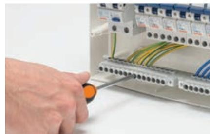
Disponibili con cablaggio a vite, le morsettiere bipolari e unipolari consentono di realizzare cablaggi veloci poiché le viti delle cave sono fornite già svitate. Le morsettiere possono essere fissate direttamente sui fondi dei centralini oppure mediante adattatore.
