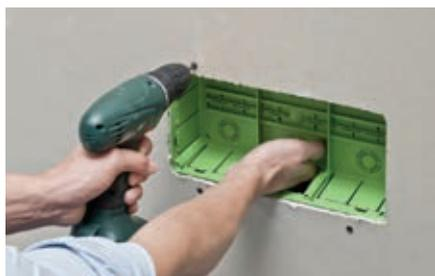
Le alette di fissaggio presenti sui contenitori permettono il fissaggio sull'orditura metallica o sulla lastra. Le griffe delle scatole per serie civili permettono l'installazione sulle lastre. I centrini di fissaggio permettono invece il montaggio a parete in caso di ristrutturazione.
