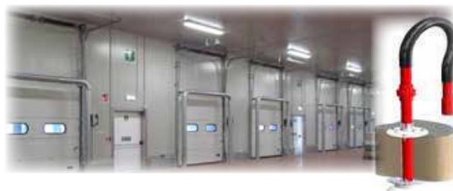
Nelle celle di refrigerazione industriale si raggiungono temperature estreme che non permettono l'utilizzo della rivelazione tradizionale. In tali applicazioni VESDA-E risulta l'unica soluzione percorribile; attraverso specifici accorgimenti installativi quali ad esempio kit di campionamento brevettati, water-trap, ecc, è possibile assicurare la rivelazione precoce anche in tali condizioni ambientali.
