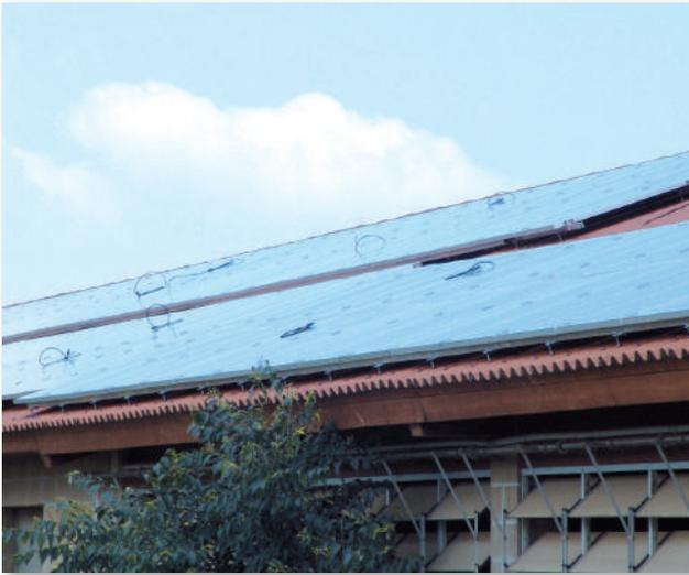
Tetto a falda-recupero amianto. Applicazione con vitoni da legno FVT1315.
