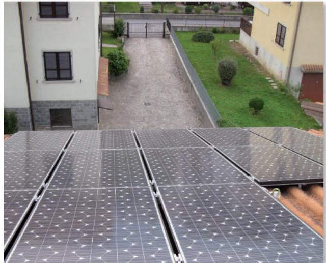
Tetto a falda con tegole. Applicazione con staffa Inox regolabile FVT1256.
