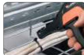
4. Azionare il grilletto. Al raggiungimento del tensionamento desiderato, scatta il taglio automatico
