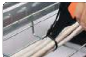
3. Inserire e appoggiare l'utensile sulla testa della fascetta
