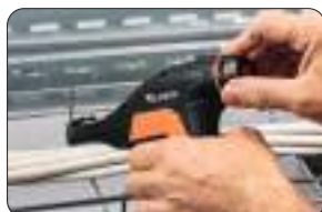
1. Regolare il tensionamento desiderato
